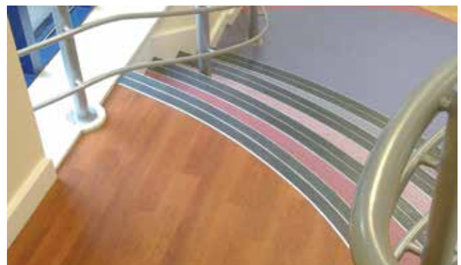
Acabado de escalera
